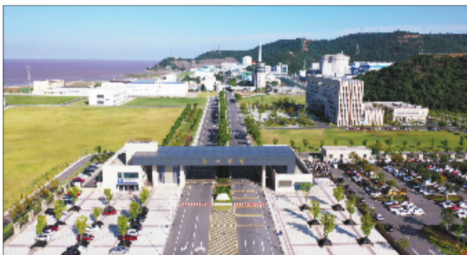
秦山核电厂区全景
