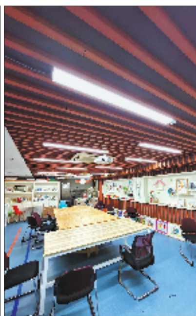
右图:杭州小营街道“残疾人之家”活动室天花板上的毫米波雷达装置非常隐蔽,可实现无感监护。
