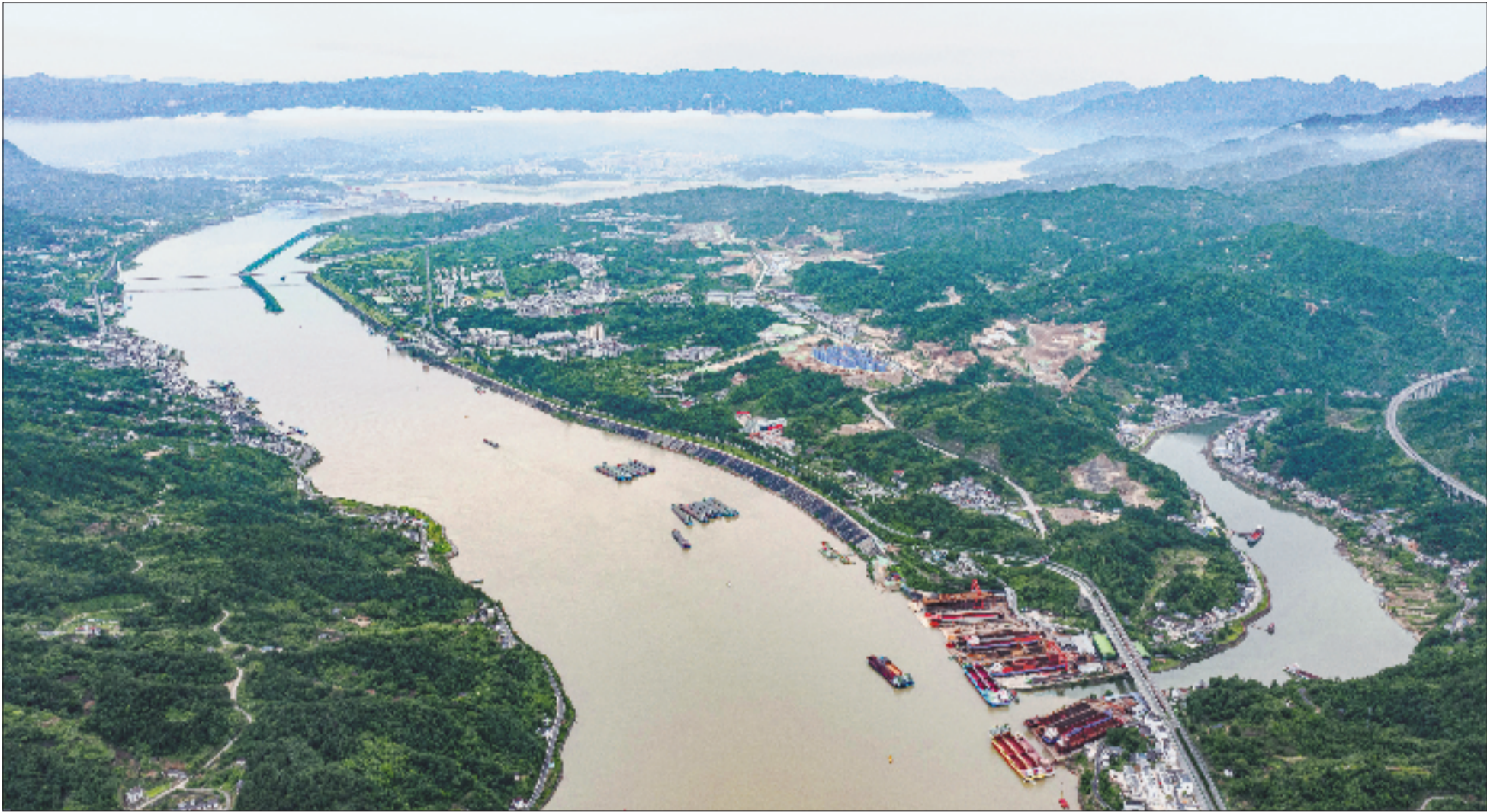
6月8日拍摄的三峡水运新通道工程三峡枢纽新通道施工现场。
