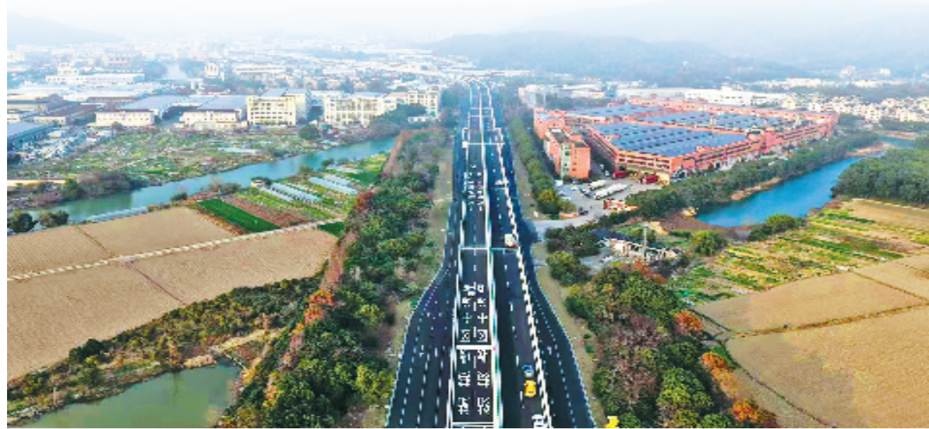
临海城市快速路(南区段)工程高架桥主线
