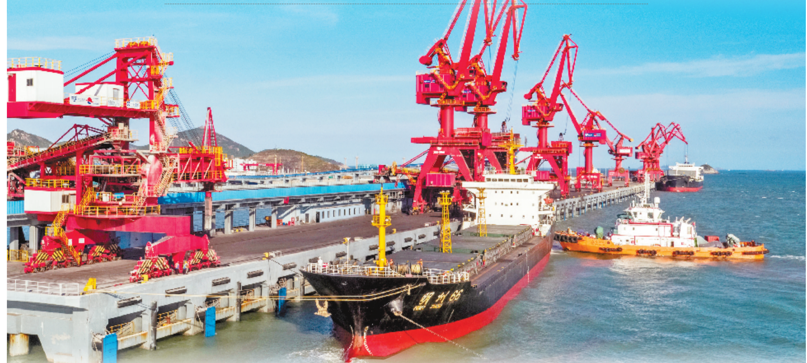
台州湾经济技术开发区头门港码头
