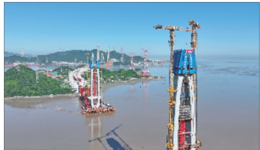
建设中的富翅门公铁两用大桥。
