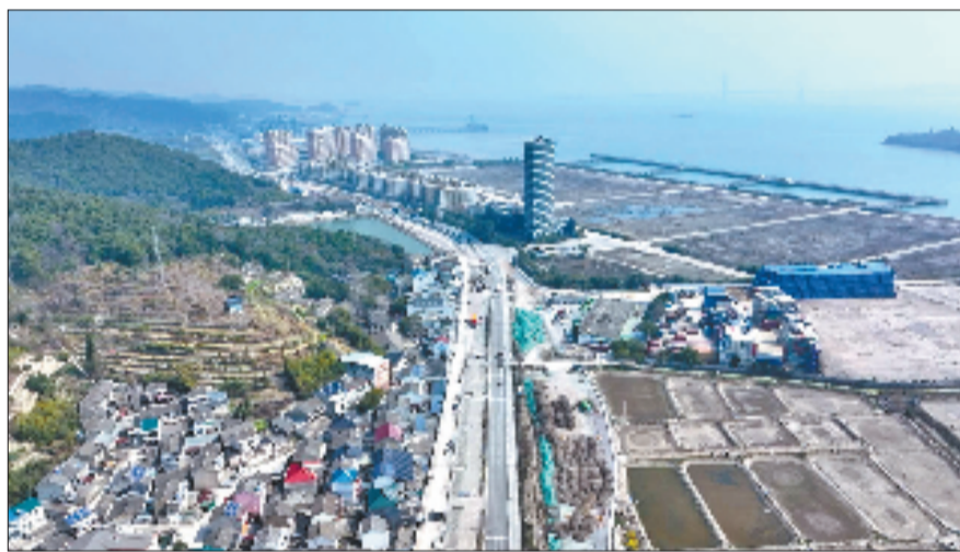
沿海中线奉化段拓宽工程施工现场
