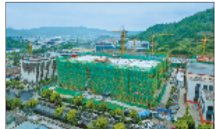
通用智能机器人二号产业园(在建)
