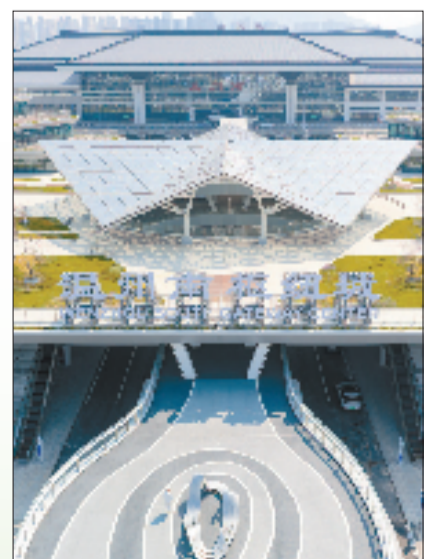
铁路温州南站直通温州园博园
