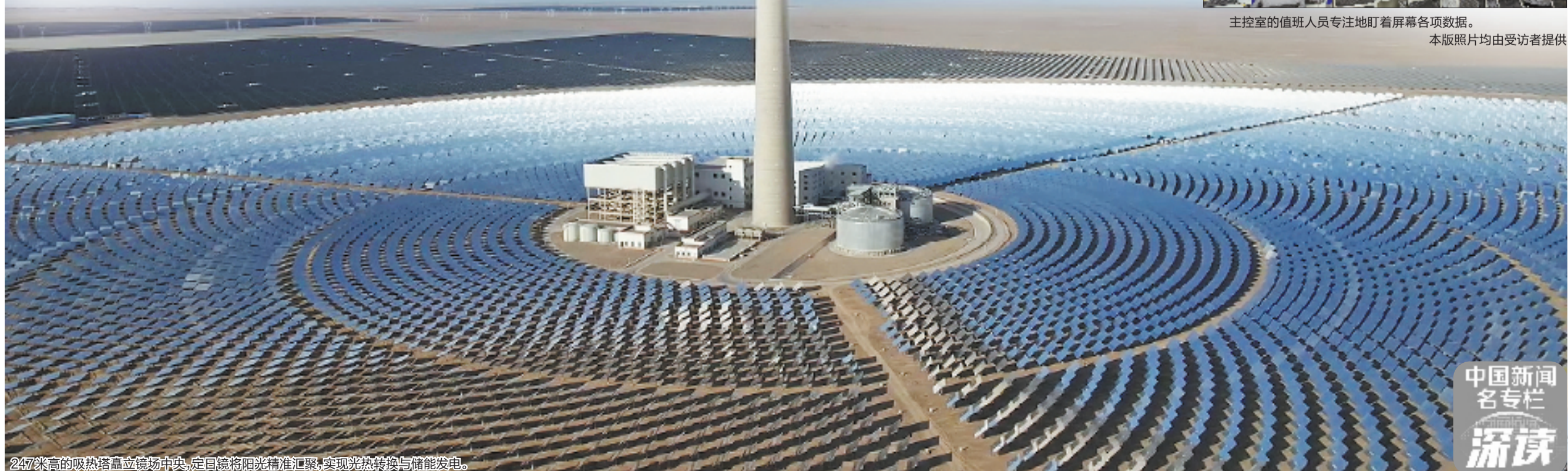
247米高的吸热塔矗立镜场中央,定日镜将阳光精准汇聚,实现光热转换与储能发电。
