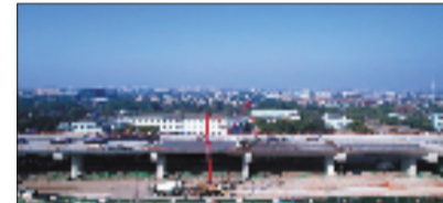
228国道慈溪北段桥面浇注
