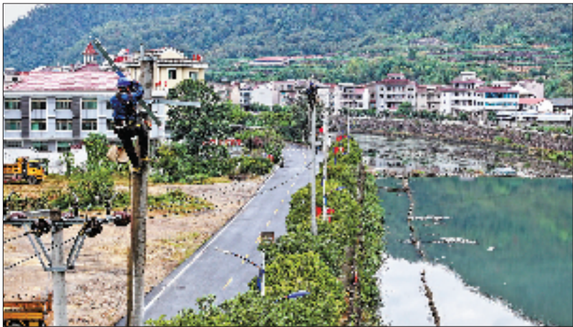
国网磐安县供电公司大力实施农村电气化提升工程,通过实地走访制定“一村一方案”,推进农网升级。目前,公司已为27个乡村完成电网改造,累计新建改造线路89.768公里,新增变压器26台,同时推进“上改下”和户联线美化工程,实现路灯亮化全覆盖。图为双溪乡史姆村改造工程现场。
