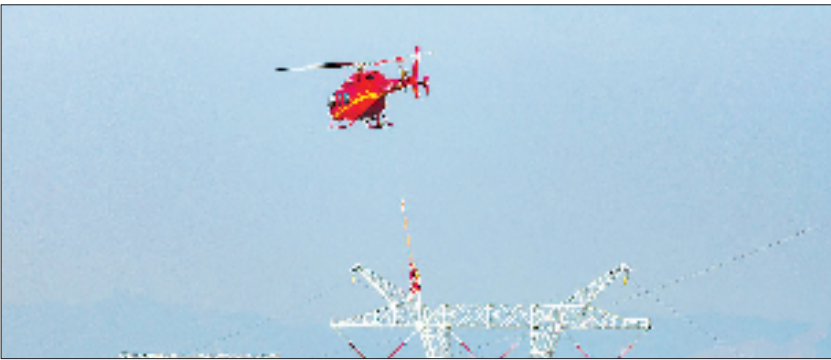
12月11日,国网衢州供电公司应用直升机绞车吊椅法完成特高压地线带电检修。
