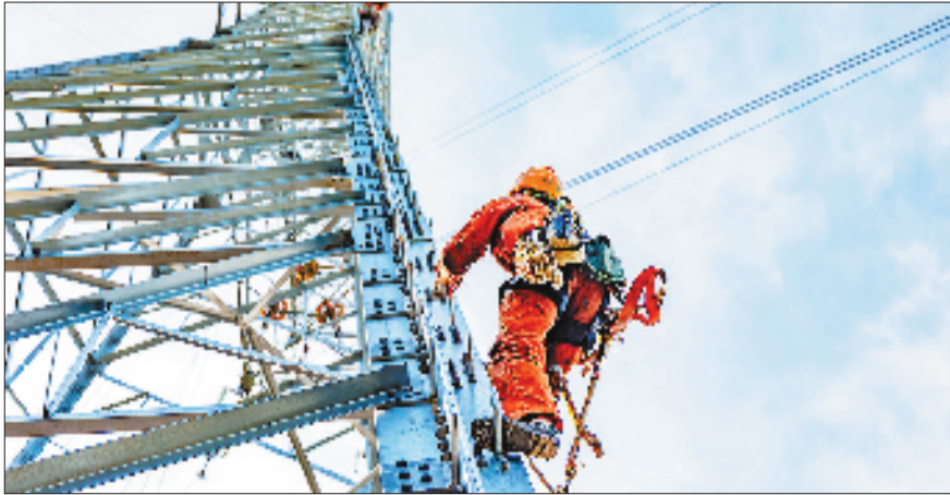
大有集团工作人员在220千伏严州—龙隐输电线路开展立塔架线工作 杨金山 摄
