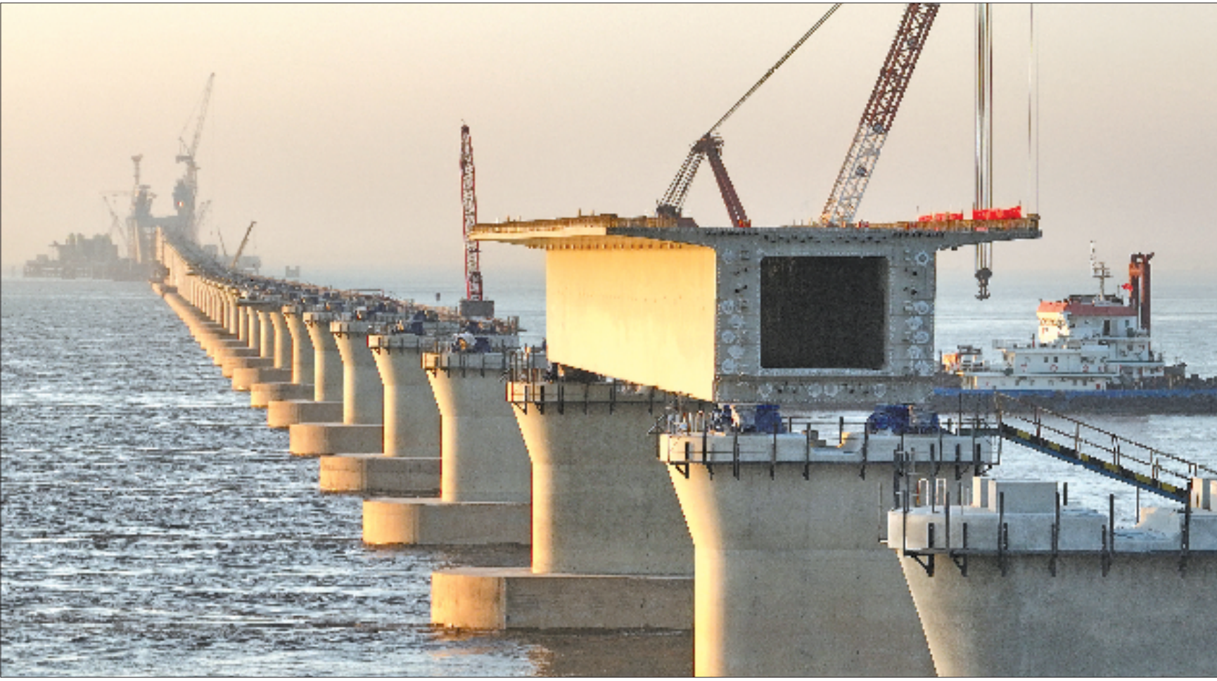
11月29日,杭州湾跨海铁路大桥宁波侧开启首孔箱梁架设。杭州湾跨海铁路桥全长29.2公里,采用时速350公里的双线无砟轨道设计,包括北、中、南三座航道桥和跨大堤、海中、浅滩区引桥。本次架设的首孔箱梁为80米跨径预制混凝土箱梁,整体总重达2804吨,相当于约2000辆小汽车的重量。
