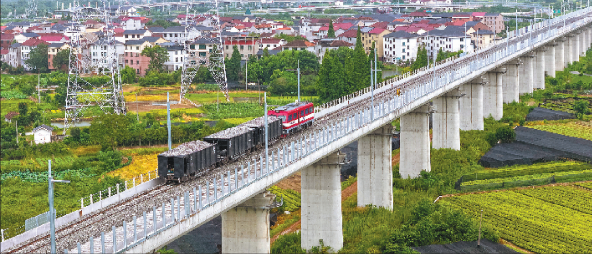
7月22日,俯瞰金建铁路金华婺城段轨道,工程列车忙于运输材料,道砟的铺设工作有序进行。目前,金建铁路已实现全线路桥隧贯通,开始进入铺轨、四电集成及站房装修的关键阶段,工程建设进入全面冲刺阶段。
