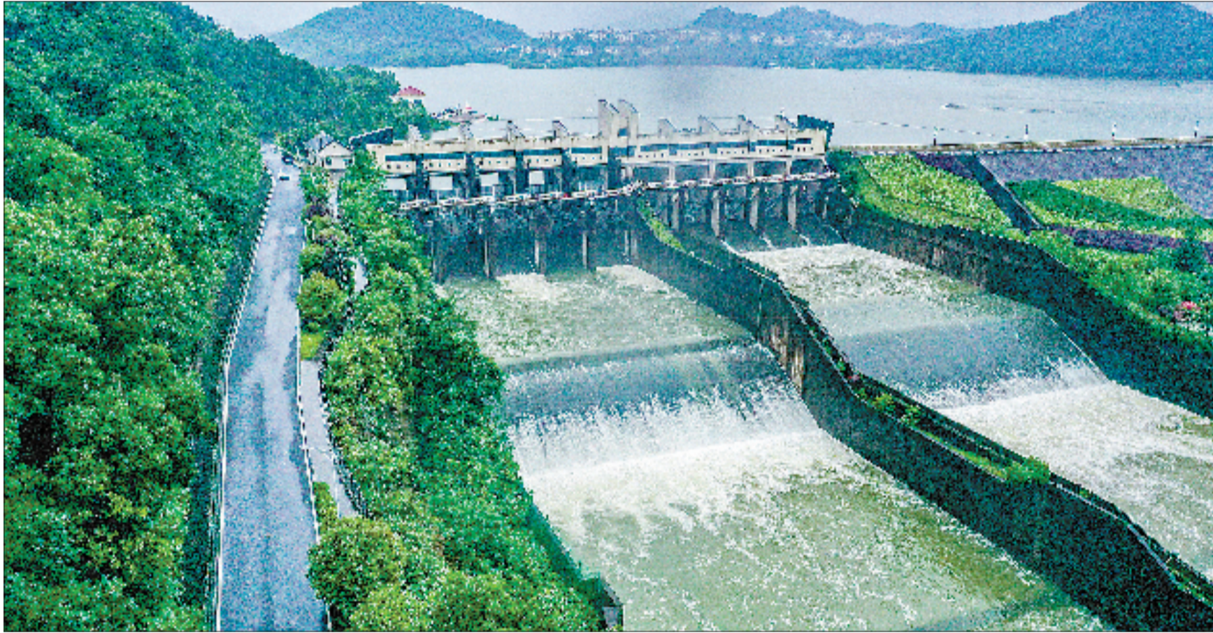
6月11日下午，杭州市临安区青山水库加大下泄至140立方米每秒（含发电），缓解上游防洪压力。据了解，青山水库位于东苕溪干流南苕溪的中下游，总库容为2.13亿立方米，控制流域面积603平方千米，为东苕溪流域上游的重要水利枢纽工程。
