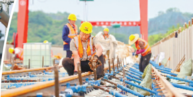
5月4日,建设者在德清县杭德市域铁路高架线铺轨现场作业。
