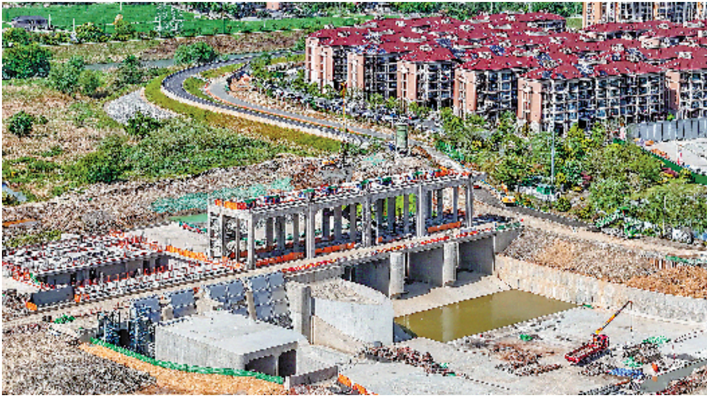
4月14日,在主汛期来临前,杭州西险大塘达标加固工程的新建南湖分洪闸已按计划完成闸门安装,并具备启闭条件。作为省“千项万亿”重大水利工程,西险大塘达标加固工程当前已完成总进度的82%,全面进入最后冲刺阶段。
