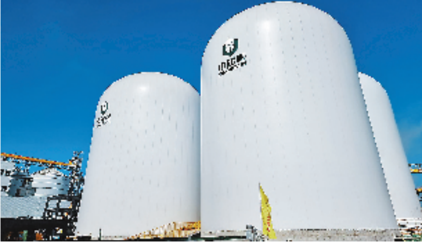
图为单仓储粮7500吨的架空式粮食气膜仓。
