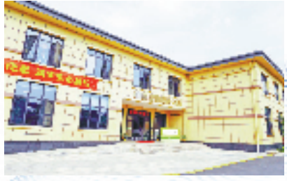
管廊运营中心
