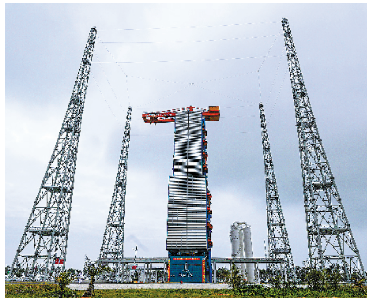
3月11日在海南文昌拍摄的海南商业航天发射场一号发射工位。
