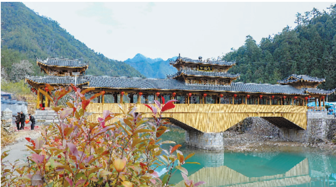
图为左溪村新建的抱龙桥。
