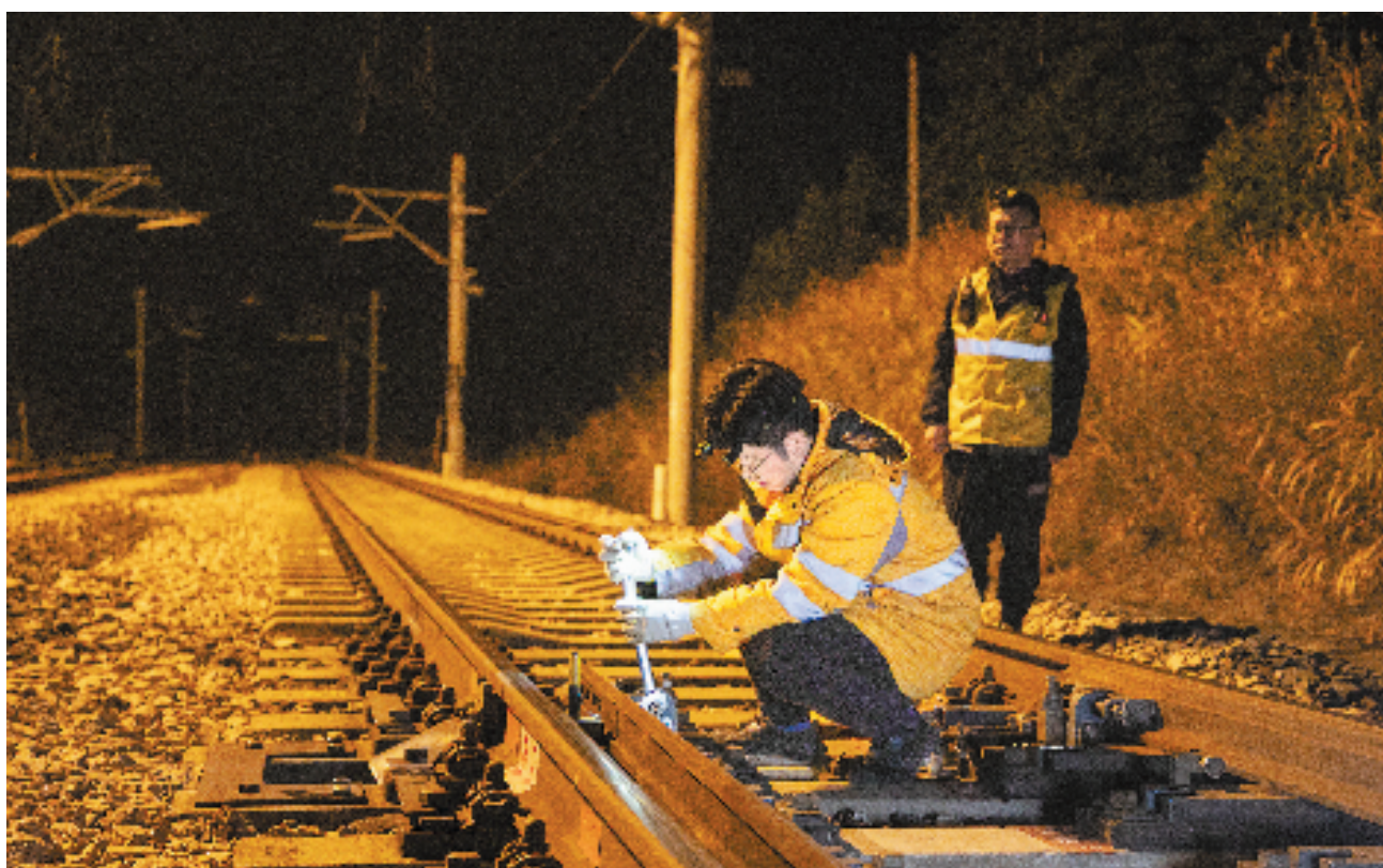
钟佳(左)与同事在线路上巡检,对线路和设备进行维修养护。
