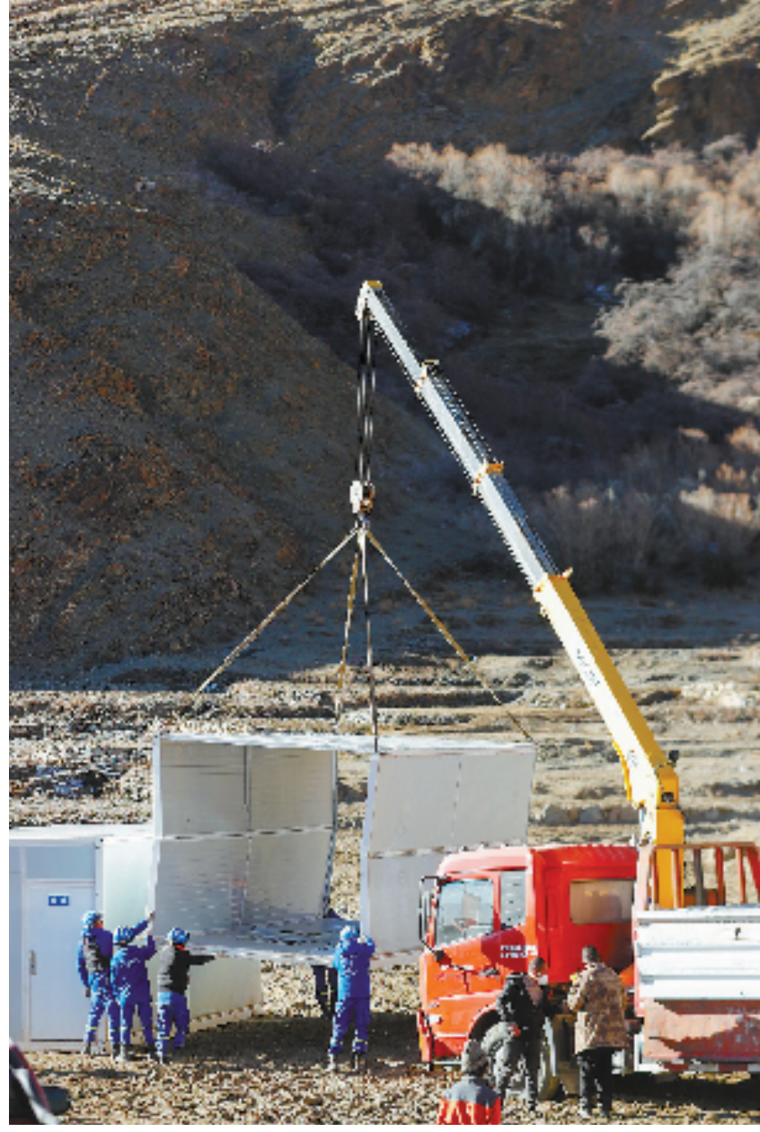
1月8日,在定日县长乡古荣村安置点,救援人员在搭建临时安置板房。新华社记者 沈铂韩 摄
