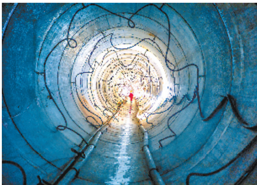
紫金港工程全线贯通
