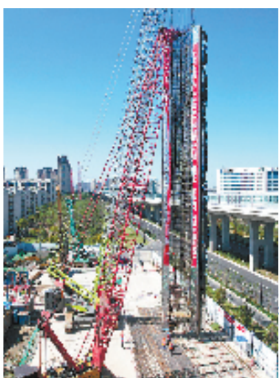
S304电力廊道项目钢筋吊装施工现场
