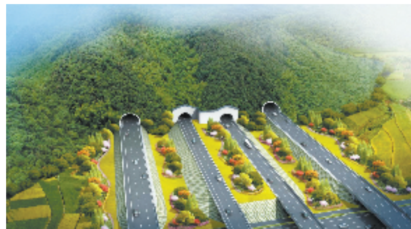
甬金改扩建金华段项目岩坑尖隧道群效果图 (图片由浙高建公司提供)
