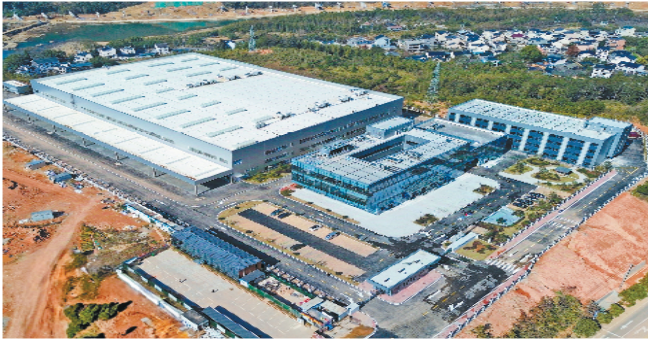
龙泉市吉利智能热管理系统制造项目(一期)。(图片由龙泉市融媒体中心提供)
