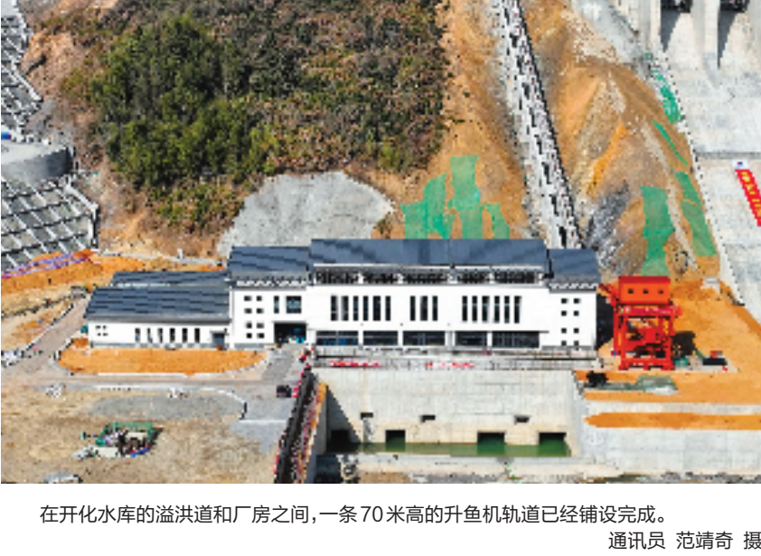
在开化水库的溢洪道和厂房之间，一条70米高的升鱼机轨道已经铺设完成。
