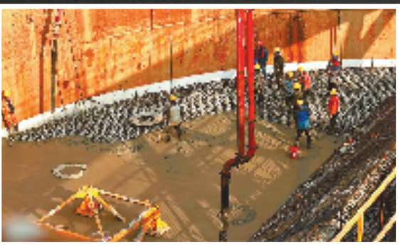
图为12月21日白天，建筑工人在加紧施工。 本报记者 倪雁强 王志杰 通讯员 黄文波 摄
