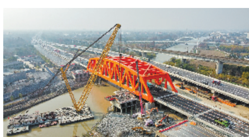
12月21日,沪杭高速长山河老桥拆除现场。
