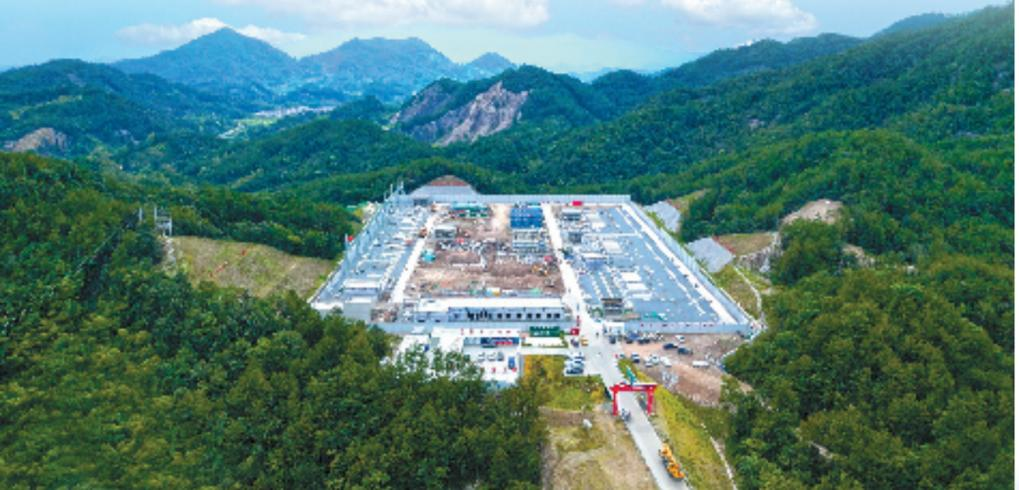
在金华市金东区，全国首个模块化建设超高压变电站500千伏潘村变全面提速。 周宁 摄
