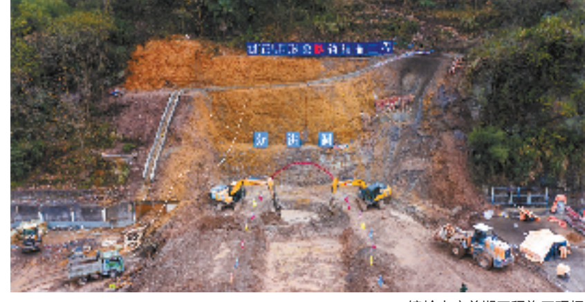
镜岭水库前期工程施工现场
