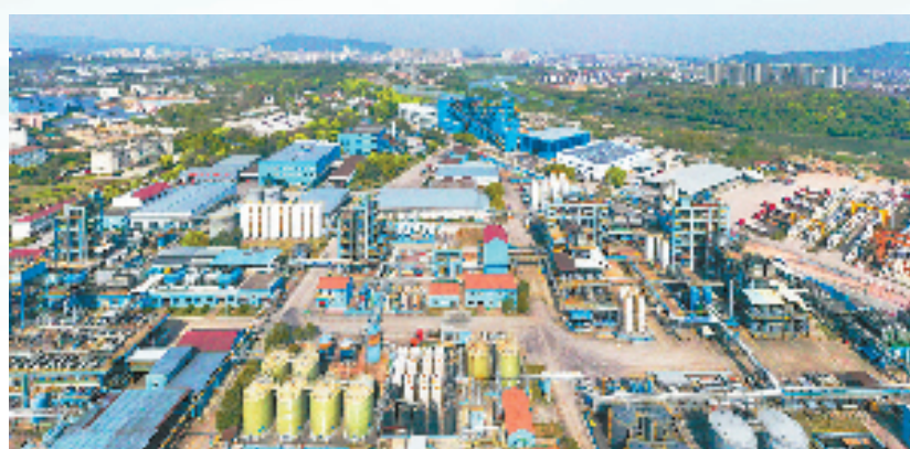
武义县新材料产业园(图片由浙江三美化工股份有限公司提供)
