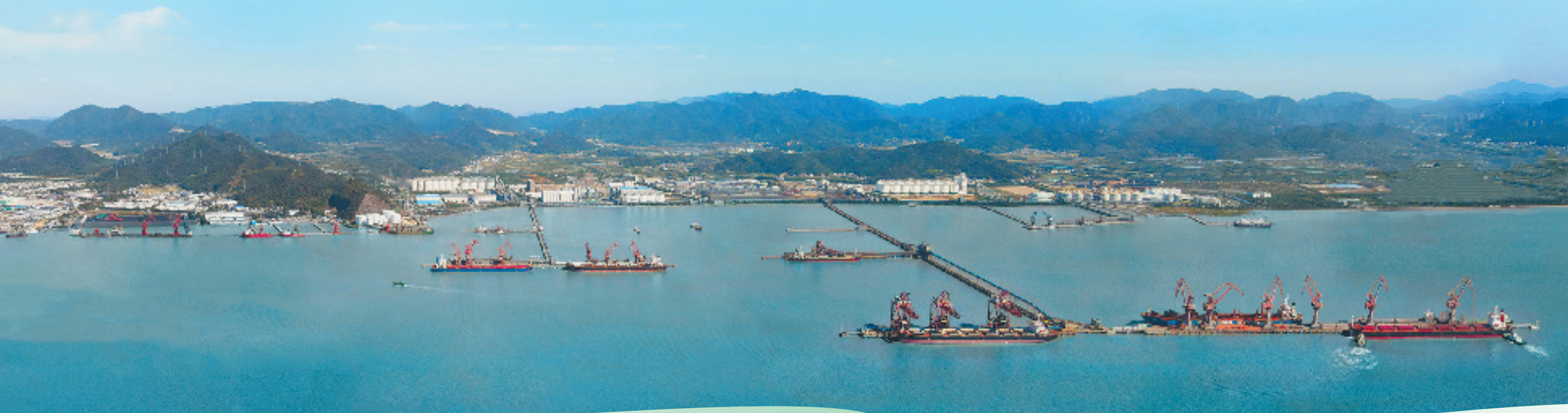
宁波舟山港老塘山作业区全景
