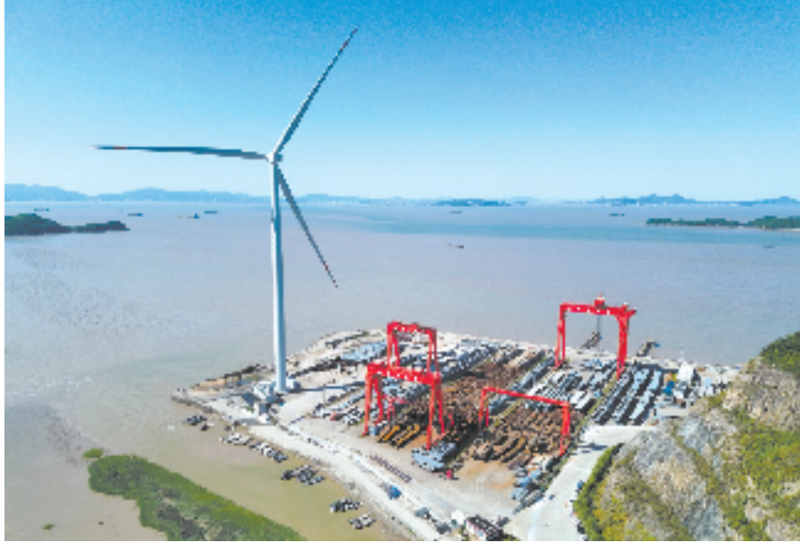
浙江波威重工厂区风光储充一体化项目
