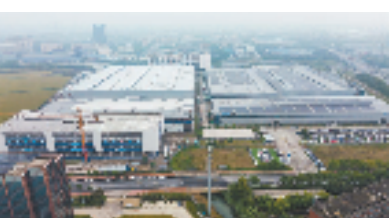
正泰二期项目现场图
