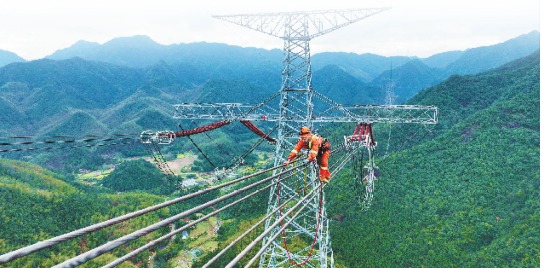
浙江送变电公司检修人员对输电线路进行走线检查。
