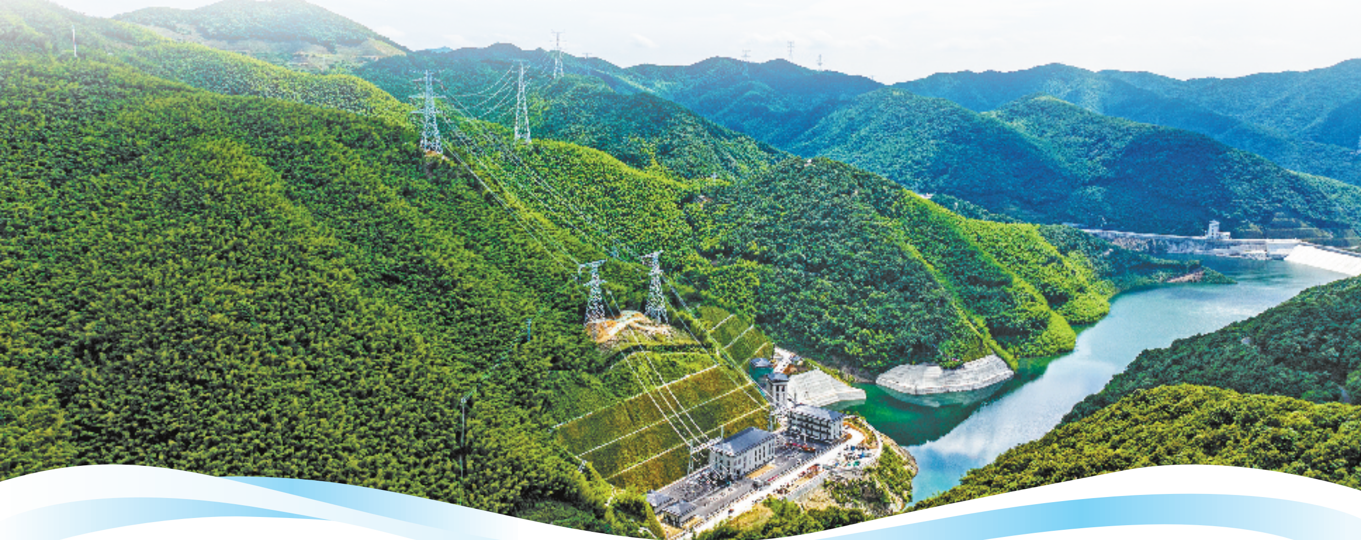
宁波首座大型抽水蓄能电站——宁海抽水蓄能电站500千伏送出工程成功投运。 胡云杰 摄
