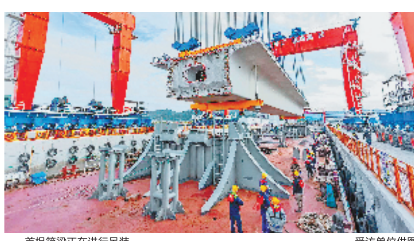
首榀箱梁正在进行吊装。
