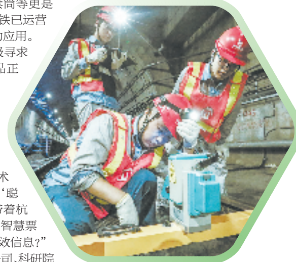
深夜，杭州地铁停运后，一线工作人员正在检查线路安全。
