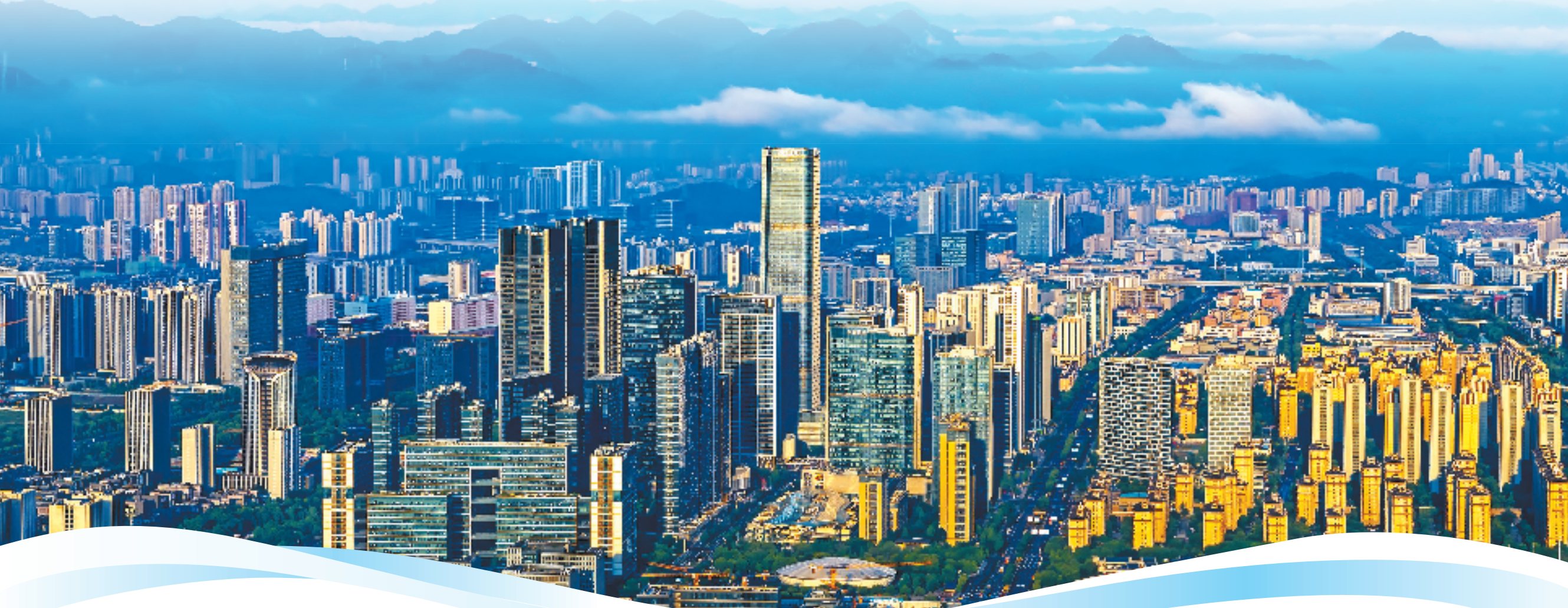
杭州未来科技城全景图
