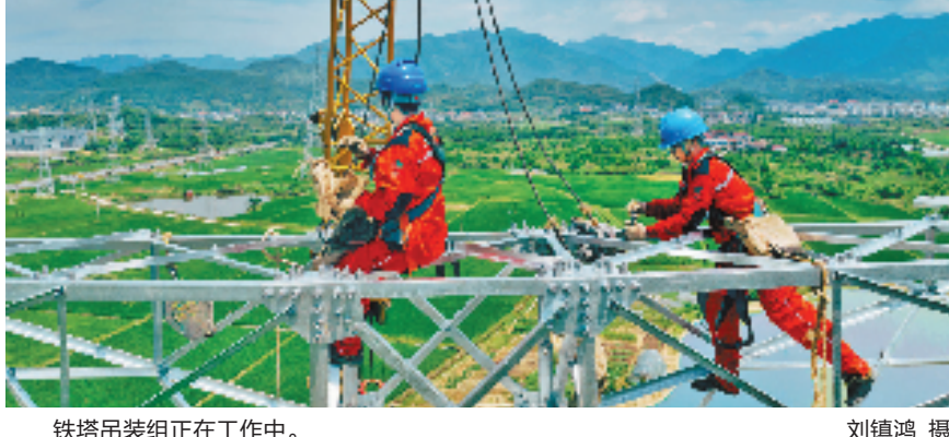
铁塔吊装组正在工作中。
