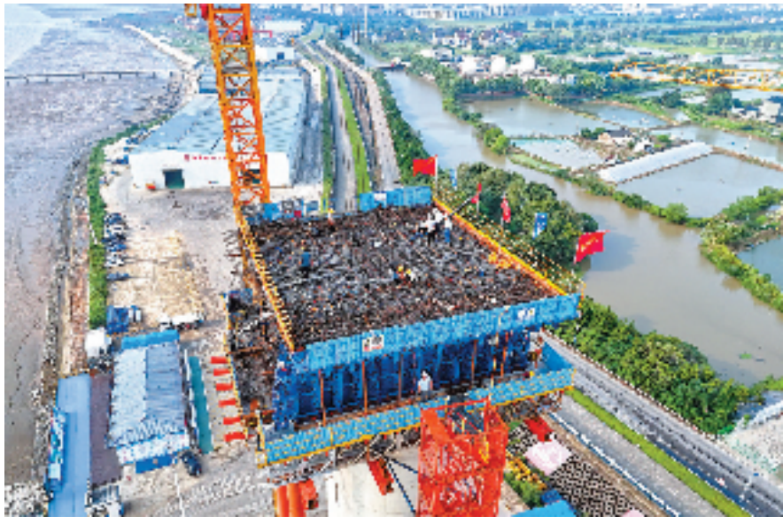
10月4日,杭州湾跨海铁路大桥跨北大堤引桥正式进入上部结构施工阶段。 本报记者 倪雁强 摄
