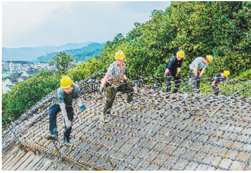
10月6日,在温岭市温峒镇焦桐村的温玉铁路温岭西站站房施工现场,工人坚守一线赶进度。 本报记者 朱海伟 摄
