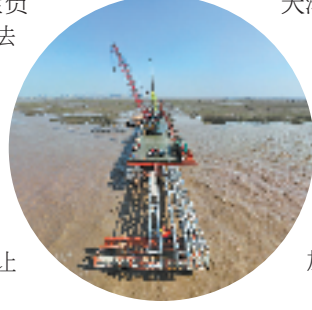
通苏嘉甬高铁 杭州湾跨海铁路大桥栈桥搭建 卓松磊 摄
