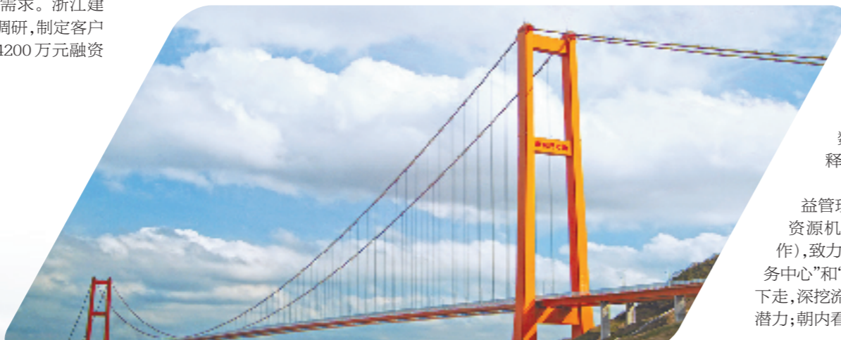
建行浙江省分行大力支持浙江交通基础设施建设,图为该行支持的舟山跨海大桥项目,以金融力量推动甬舟一体化联动发展。
