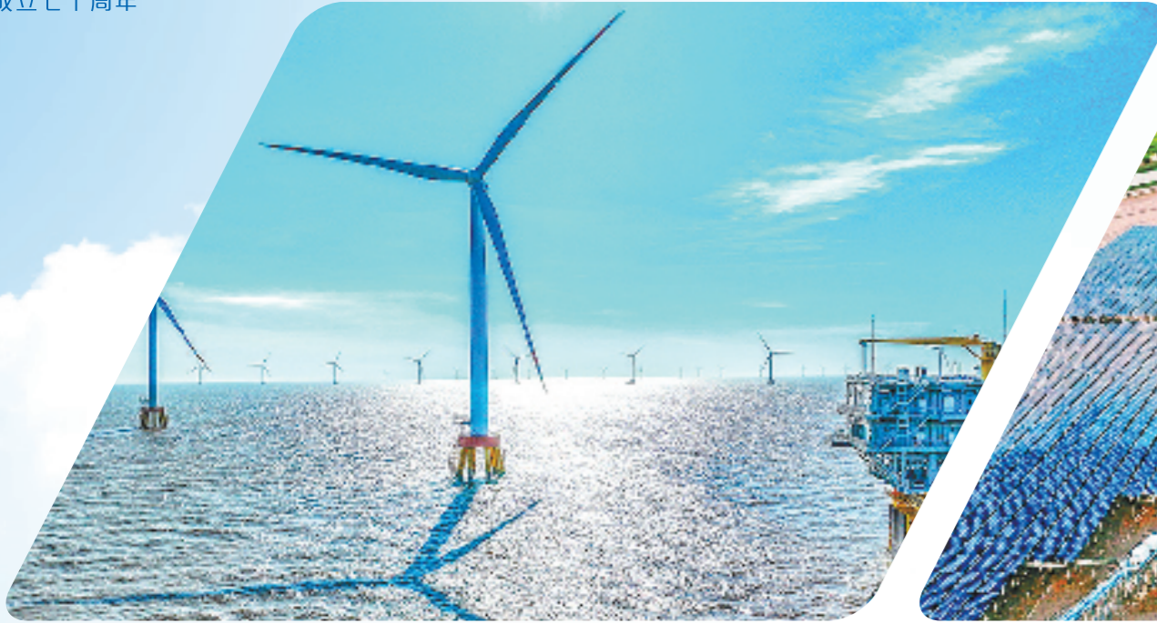
绿色金融“贷”动风力发电发展,图为建行支持的中广核岱山4号海上风电场项目。
