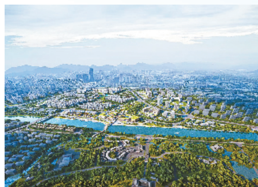
湖州市南太湖新区凤凰湾片区低效改造项目
