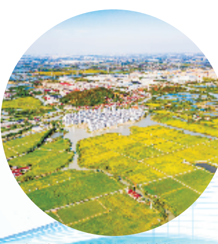
湖州市吴兴区东林镇土地综合整治项目
