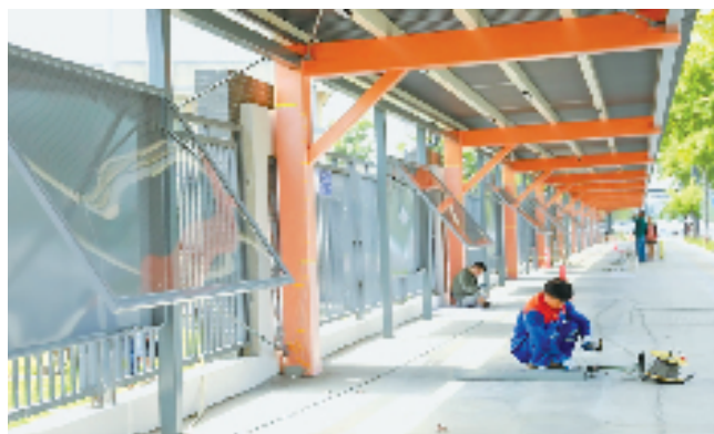
8月28日,衢州市柯城区礼贤小学的风雨长廊正在进行扫尾工作。
