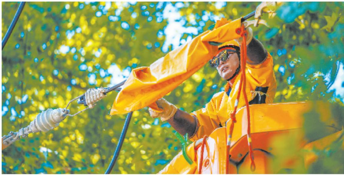
浙江浙电产业发展有限公司工作人员在杭州富阳区青云地区对10千伏厂D570线分段开关实施带负荷三类复杂带电作业，为夏季有序用电保驾护航。
