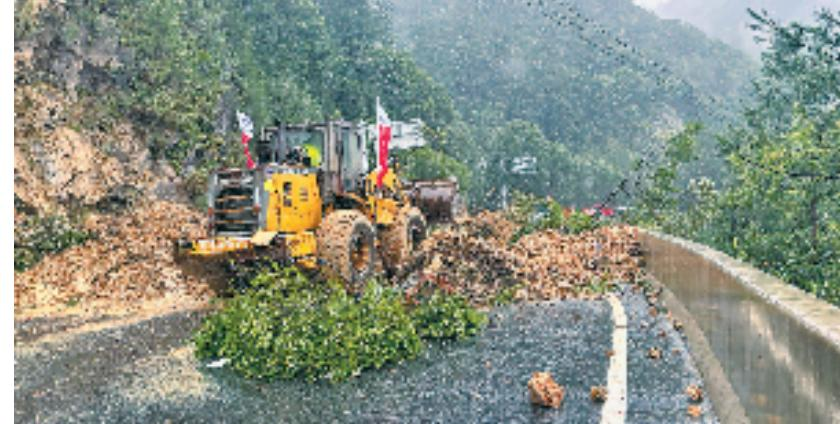
图为在景宁县G235新海线k1098+300处,公路应急抢险队伍在清理塌方路段的泥石流及土石方。
