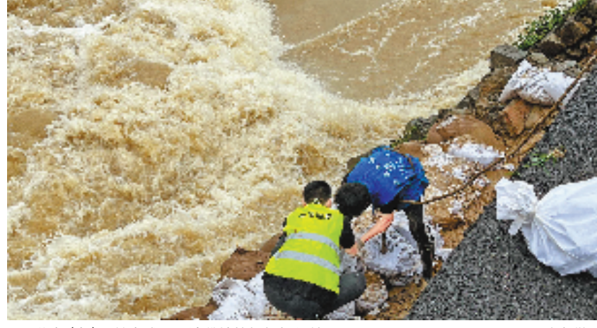
郑哲(左)和羊李成正用沙袋填堵坝脚损毁处。受访者供图
