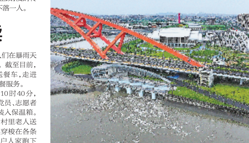
6月24日下午,杭州八堡排灌泵站开启三台泵组,以150立方米/秒的流量将杭州内河水排入钱塘江,确保城区防汛安全。 本报记者 林云龙 摄
