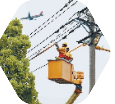
浙江大有集团员工开展引线搭接带电作业，提升线路健康运行水平。
