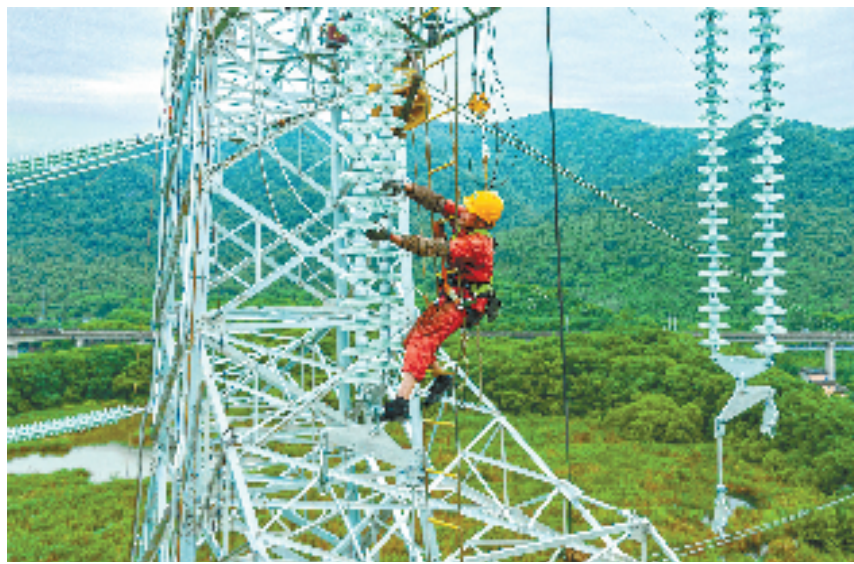
浙江大有集团员工正在立塔架线，助力长三角区域蓬勃发展。
